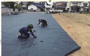
シート敷き込み (固定)
